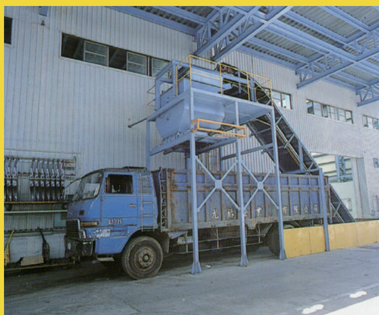
儲料筒具自動卸料功能，方便卡車載運。
